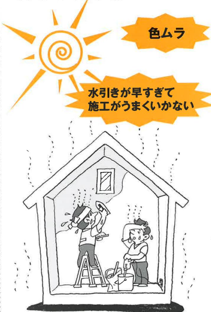
乾きが早い夏季や、大壁や吹抜けなど施工面積が広い場合は、追っかけ2度塗りの1回目の塗りには『粉つのはた』か『メトローズ』を入れて施工するなど、乾燥時間を調節する工夫をしてください。2回目には『粉つのはた』『メトローズ』は入れない方が施工が楽です。(入れる量は、気象条件に応じて現場で調整してください。)
