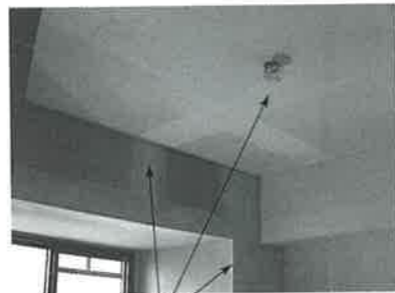
クロス用のパテが塗られているところがボードのジョイント部です。
