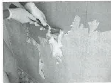
下紙がふやけたタイミングをみて、スクレーパーで剥がしてください。
